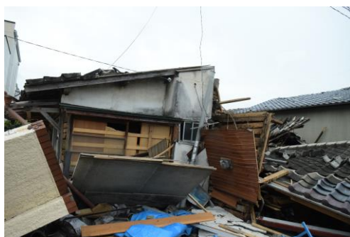
震災で倒壊した家 (熊本県益城町)
