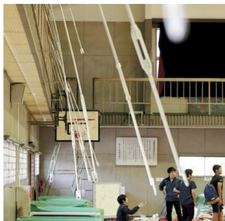
内壁が落ち床に突き刺さった市立東部中学校の体育館 (毎日新聞2016年4月27日引用)
